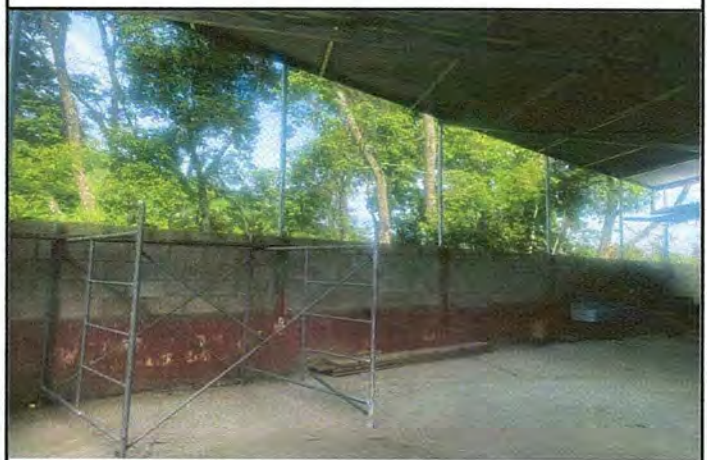
Foto 4: Renglón 2 muro perimetral
