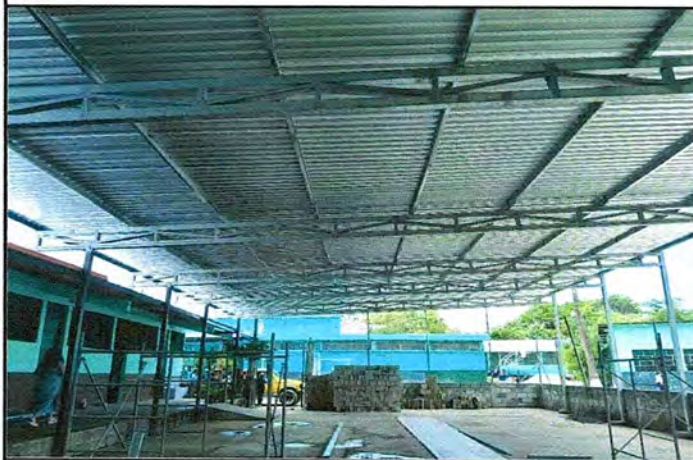
Foto 3: Renglón 1 techo de patio
