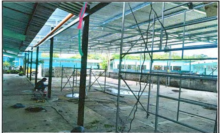
Foto 2: Renglón 1 techo de patio
