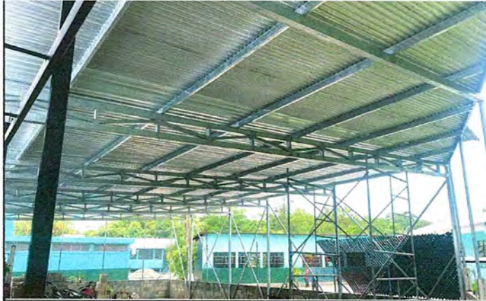
Foto 1: Renglón 1 techo de patio
